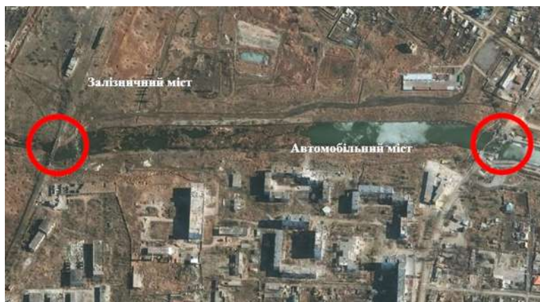
Рис. 15. Зруйновані автомобільний та залізничний мости через річку Бахмутка станом на березень 2023 року [16].
